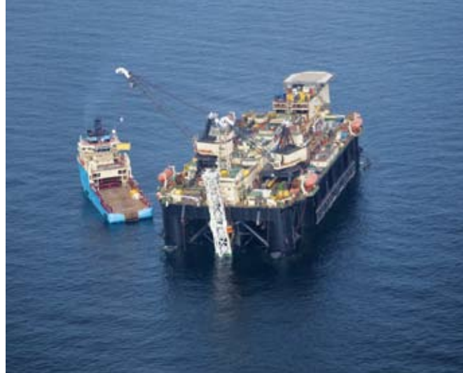
Putkenlaskualus "Castoro Sei" ja putkien kuljetusalus. Turva-alue aluksen ympärillä on 3 km.
